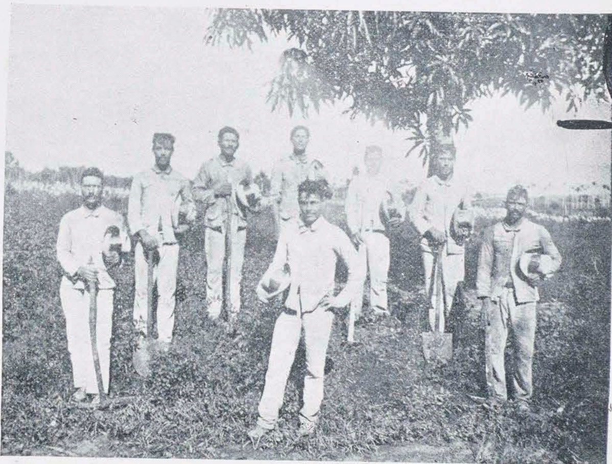
Soldados del ejército libertador, hoy peones camineros de Bejucal, que hicieron los trabajos de excavación.
