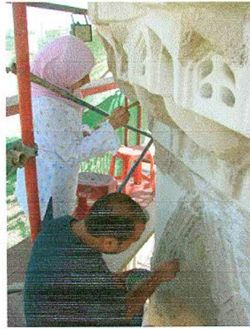
View of fine restoration and cleaning activities and completion of missing part of the stucco stalactites منظر يوضح أنشطة الترميم الدقيق وأنشطة التنظيف واستكمال الأجزاء المفقودة من الزخارف الجصية بالمقرنصات
