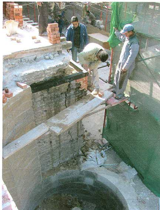
Brick repair and stitching on the main façade أعمال ترميم وربط المباني الطوب بالواجهة الرئيسية
