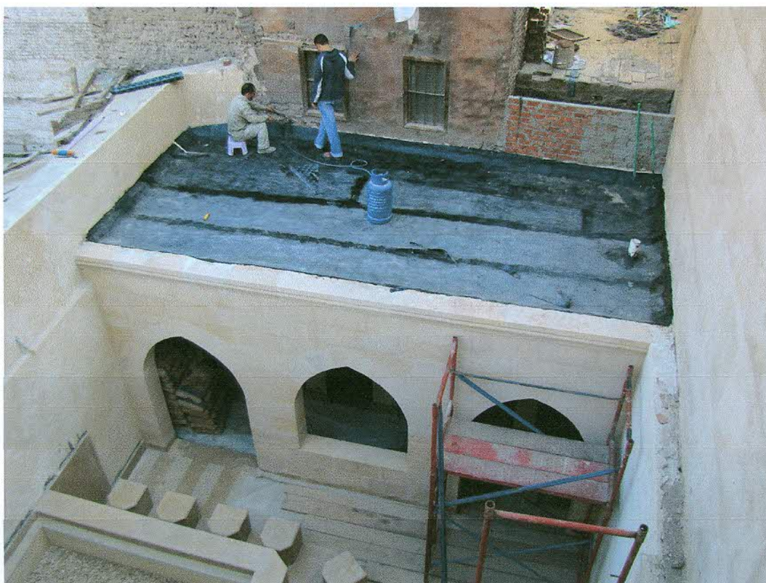
Insulation of the ablution roof أنشطة العزل بسطح الحمامات
