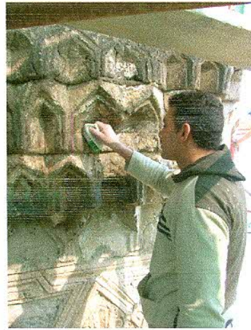
View of fine restoration and cleaning activities and completion of missing part of the stucco stalactites منظر يوضح أنشطة الترميم الدقيق وأنشطة التنظيف واستكمال الأجزاء المفقودة من الزخارف الجصية بالمقرنصات
