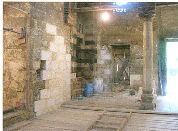
Replacement of damaged marble استبدال الرخام التالف بمدخل الضريح
