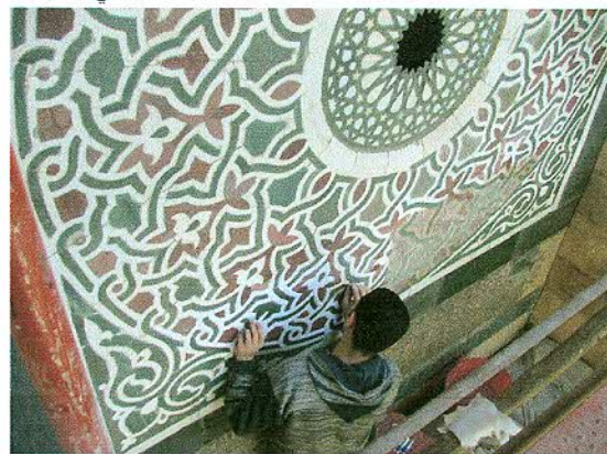
Cleaning of marble panel on southern facade تنظيف اللوحة الرخام بالواجهة الجنوبية
