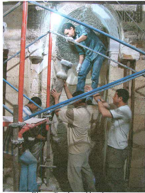
Dismantling the marble columns فك الأعمدة الرخام لإستبدال القواعد التالفة
