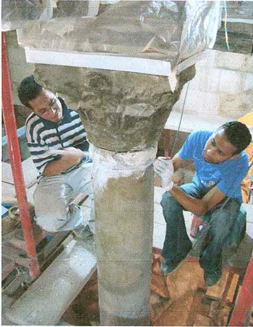
Cleaning the marble columns in the mosque courtyard تنظيف الأعمدة الرخام بصحن المسجد
