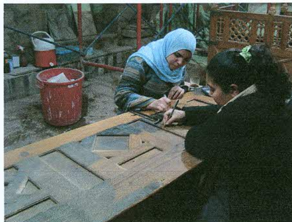
Cleaning and consolidation of the metal grill windows and doors تنظيف وتقوية المصبغات الحديدية والشبابيك والأبواب
