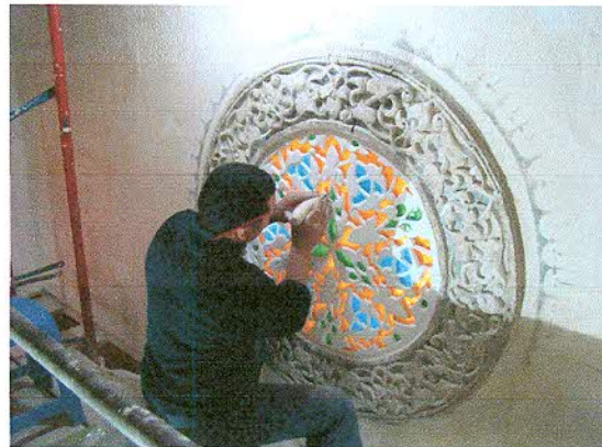
Cleaning and consolidation of the stucco decorations Completing the missing gypsum roundel تنظيف وتقوية الزخارف الجصية واستكمال الإطارات الدائرية المفقودة
