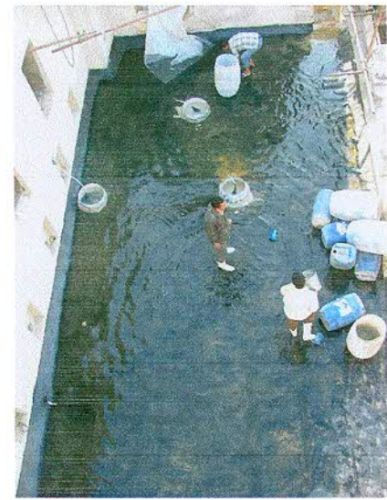
Testing the roof insulation عملية اختبار العزل بالأسطح
