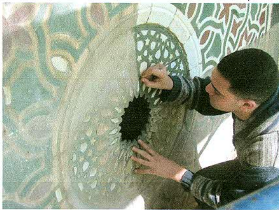
Cleaning of marble panel on southern facade تنظيف اللوحة الرخام بالواجهة الجنوبية
