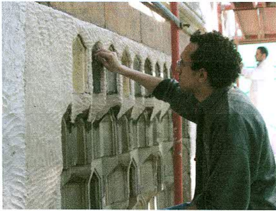
Chemical cleaning of stone stalactites and marble on the main facade التنظيف الكيميائي للمقرنصات والرخام بالواجهة الرئيسية
