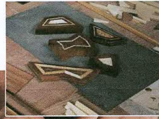
Restoration and cleaning of the wooden elements and replacement of missing carved parts ترميم وتنظيف العناصر الخشبية المزخرفة واستكمال الأجزاء المفقودة
