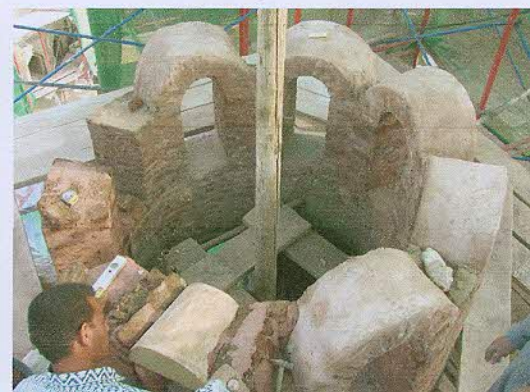
أعمال ترميم المباني الطوب بالمئذنة
