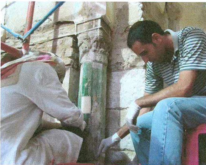
Cleaning and completing eroded parts of the qibla iwan marble columns أعمال تنظيف واستكمال الأجزاء التالفة من الأعمدة الرخام بمحراب إيوان القبلة
