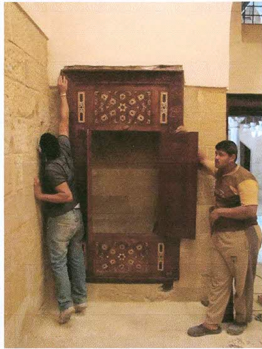
installation of the mausoleum cupboards تركيب دواليب الحوائط بالضريح بعد ترميمها
