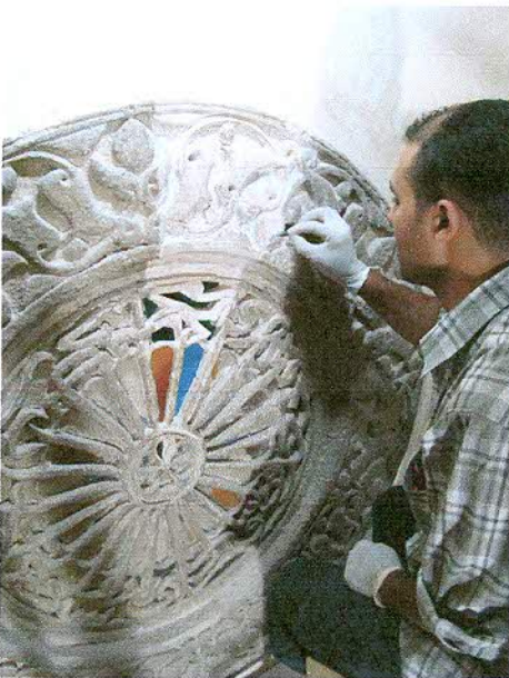
Cleaning and consolidation of the stucco decorations Completing the missing gypsum roundel تنظيف وتقوية الزخارف الجصية واستكمال الإطارات الدائرية المفقودة
