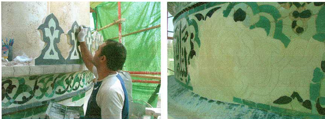
Restoration and completing the missing crenellations and inscription using mortar and re-touching it ترميم واستكمال الشرفات المفقودة والشريط الكتابي باستخدام المونة وتقنية التثبيت
