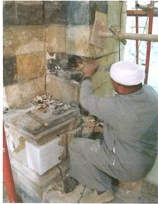
Replacement of damaged marble استبدال الرخام التالف بمدخل الضريح
