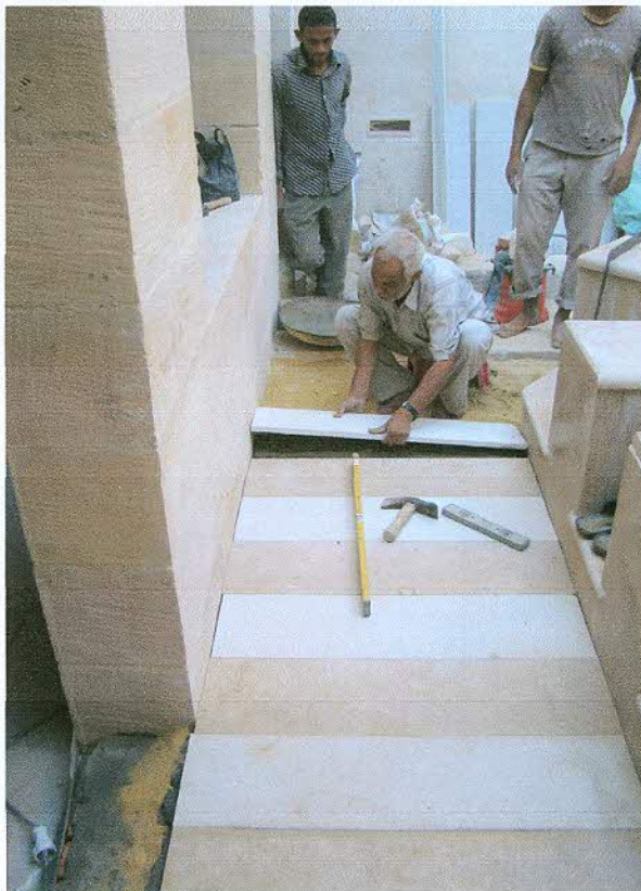
Tiling activities in the ablution area أنشطة التبليل بمنطقة الوضوء
