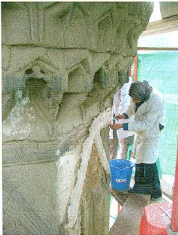
View of fine restoration and cleaning activities and completion of missing part of the stucco stalactites منظر يوضح أنشطة الترميم الدقيق وأنشطة التنظيف واستكمال الأجزاء المفقودة من الزخارف الجصية بالمقرنصات
