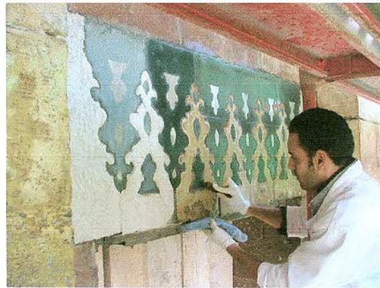
Chemical cleaning of stone stalactites and marble on the main facade التنظيف الكيميائي للمقرنصات والرخام بالواجهة الرئيسية
