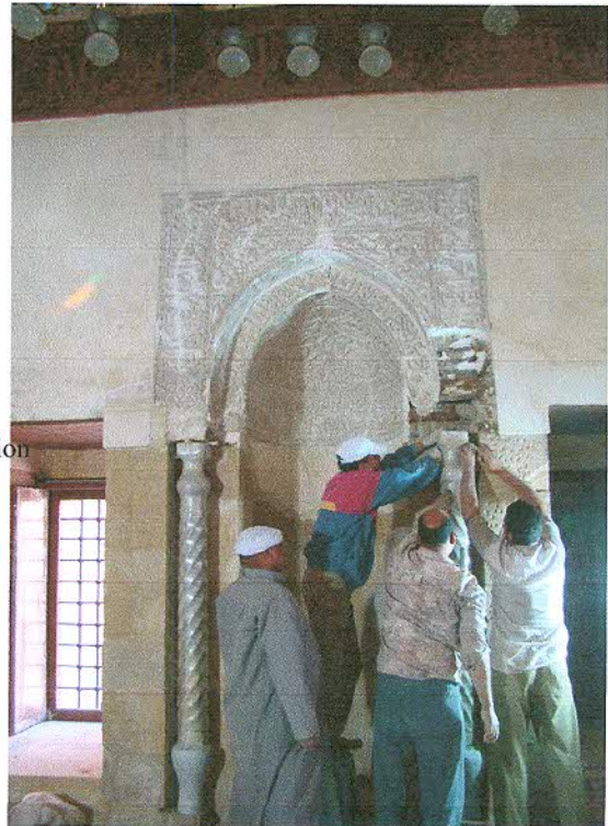
Fixing of the marble columns after consolidation إعادة تثبيت الأعمدة الرخام بعد تقويتها
