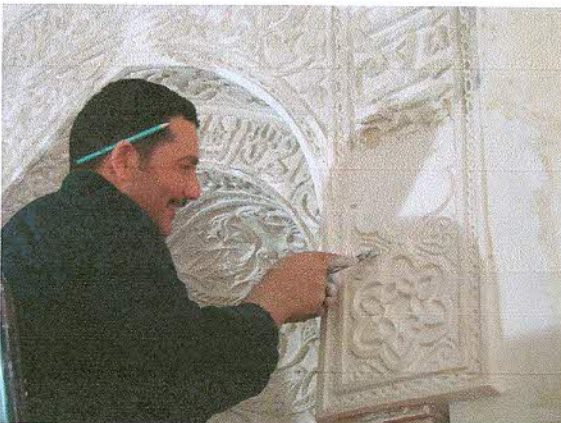
Mechanical cleaning and completion of the stucco inscription التنظيف الميكانيكي واستكمال الشريط الجصي بالمحراب
