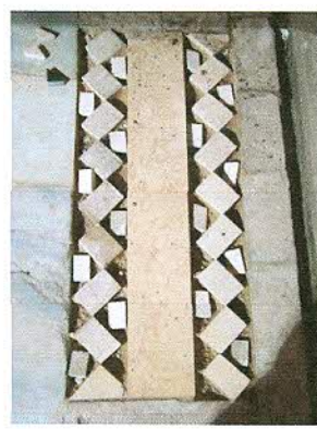
The mosque courtyard marble tiling during conservation الأرضية الرخام أثناء أعمال الترميم
