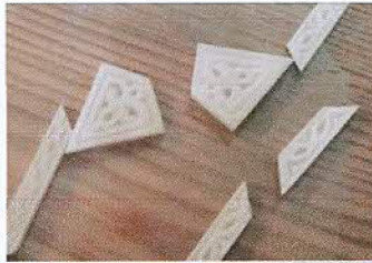
Restoration and cleaning of the wooden elements and replacement of missing carved parts ترميم وتنظيف العناصر الخشبية المزخرفة واستكمال الأجزاء المفقودة
