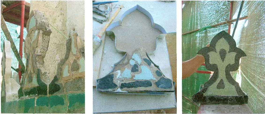
Restoration and completing the missing crenellations and inscription using mortar and re-touching it ترميم واستكمال الشرفات المفقودة والشريط الكتابي باستخدام المونة وتقنية التثبيت
