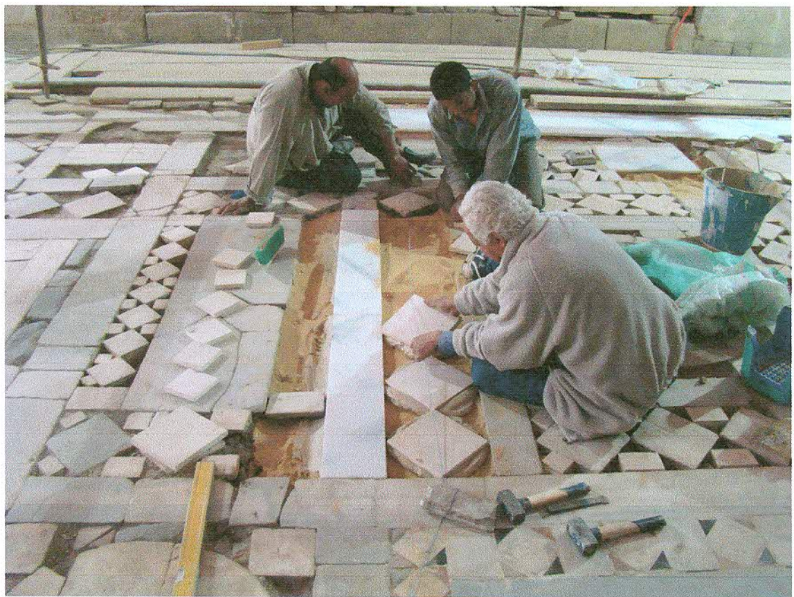
The mosque courtyard marble tiling during conservation الأرضية الرخام أثناء أعمال الترميم
