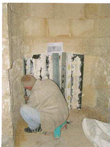
Replacement of stone and marble panels reconstruction in the qibla mihrab تغيير الأحجار التالفة وتركيب ألواح الرخام بمحراب القبلة
