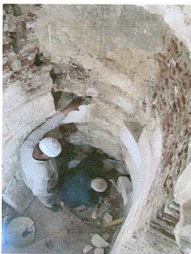
Replacement of stone and marble panels reconstruction in the qibla mihrab تغيير الأحجار التالفة وتركيب ألواح الرخام بمحراب القبلة
