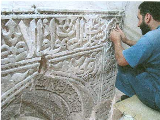
Mechanical cleaning and completion of the stucco inscription التنظيف الميكانيكي واستكمال الشريط الجصي بالمحراب
