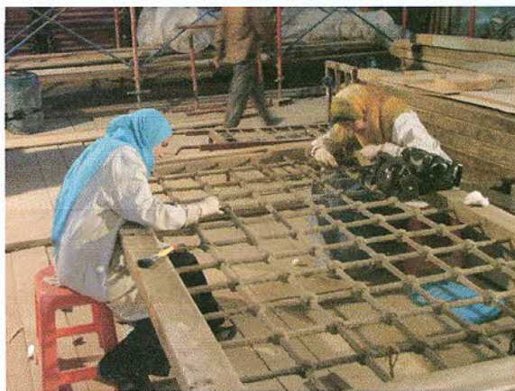
Cleaning and consolidation of the metal grill windows and doors تنظيف وتقوية المصبغات الحديدية والشبابيك والأبواب
