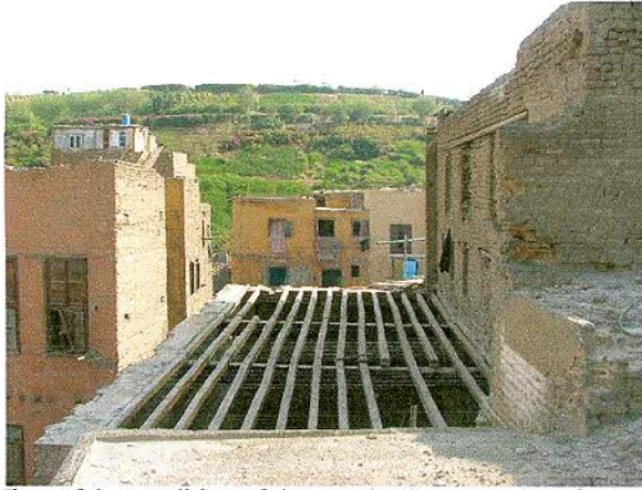
View of the condition of the wooden beams and roofs منظر يوضح حالة الأسقف الخشبية والأسطح عند بدء المشروع
