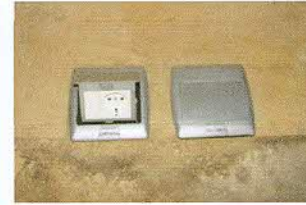
Ground mounted plugs قابس الكهرباء بالأرضية
