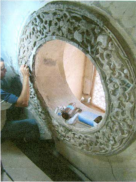
Cleaning and consolidation of the stucco decorations Completing the missing gypsum roundel تنظيف وتقوية الزخارف الجصية واستكمال الإطارات الدائرية المفقودة
