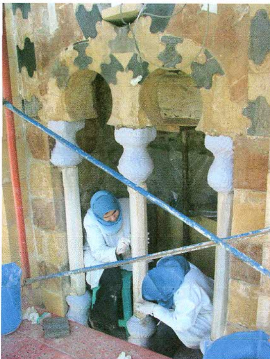
Cleaning of marble columns تنظيف الأعمدة الرخام بالشبابيك
