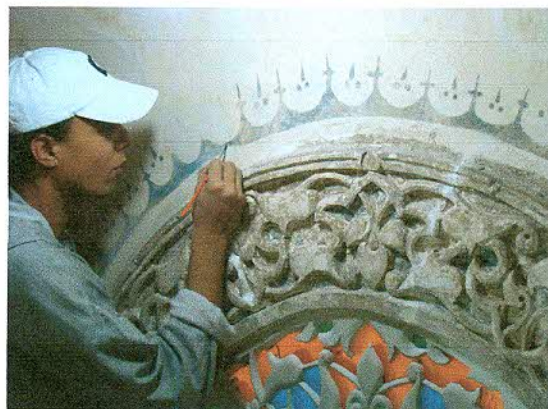
Retouching of the original colours around the roundel أعمال إظهار الألوان الأصلية حول الإطارات الجصية
