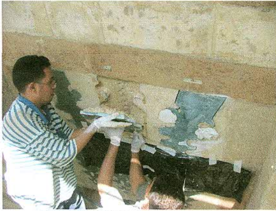
Fixing detached marble decorations تثبيت الأجزاء المنفصلة من الرخام
