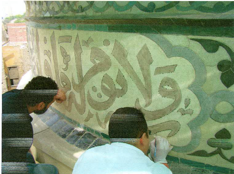
Completion of the missing parts of the inscription band by re-pointing استكمال الأجزاء المفقودة من الشريط الكتابي باستخدام طريقة التثقيب
