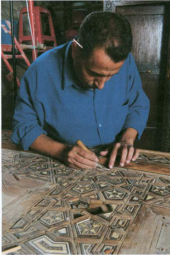
Restoration and cleaning of the wooden elements and replacement of missing carved parts ترميم وتنظيف العناصر الخشبية المزخرفة واستكمال الأجزاء المفقودة
