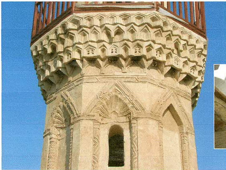
View of fine restoration and cleaning activities and completion of missing part of the stucco stalactites منظر يوضح أنشطة الترميم الدقيق وأنشطة التنظيف واستكمال الأجزاء المفقودة من الزخارف الجصية بالمقرنصات
