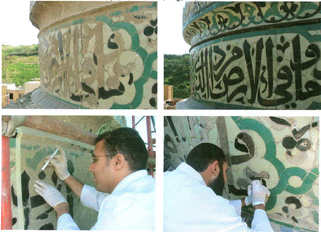
Fixing of the detached and flaking glazed ceramic حقن وتثبيت الأجزاء المنفصلة من السيراميك
